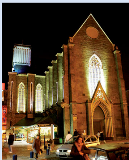
L'église Saint-Guillaume, un des chantiers réalisés dans le cadre du Plan Pluriannuel d'Entretien.
