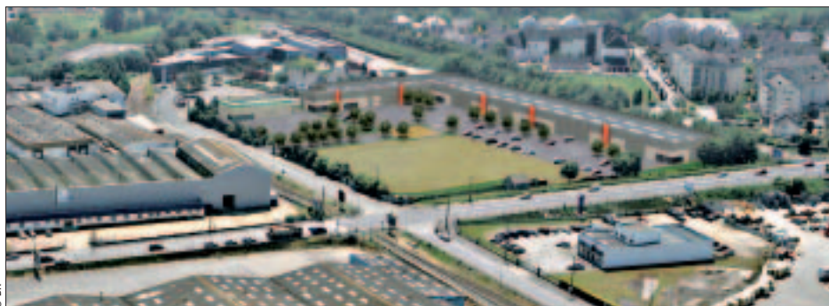
Les futurs locaux que le groupe Mazureau implantera sur le site de l'ancien abattoir, face à Promodes, dont la démolition s'achève.
