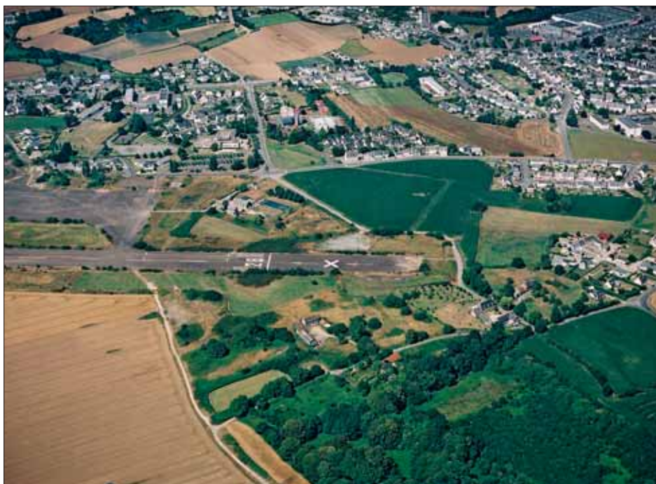
La ZAC des Plaines Villes, d'une superficie de près de 120 hectares, s'inscrit à l'Ouest de notre territoire et sur la commune voisine de Ploufragan.
