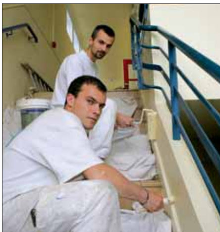
Des peintures ont été refaites à Hoche cet été, un chantier parmi d'autres.
