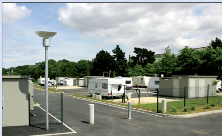
La Ville de Saint-Brieuc vient d'ouvrir l'aire d'accueil située à la Ville Bernard, conformément à la décision unanime prise par le Conseil Municipal en 2004.
